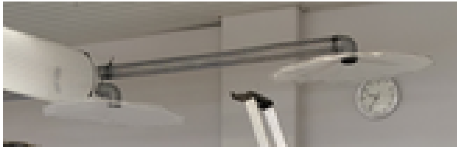
Abbildung 10: Zentralrohr, Verbindungsrohre und Hauben
