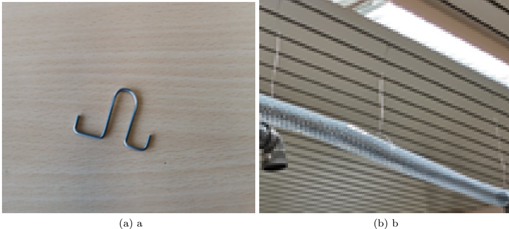
Abbildung 13: Zur Befestigung an der Decke: (a) Aus 1.5 mm Federstahldraht gebogene Haken/Ösen zur Befestigung an der Decke und (b) Eisendraht verzinkt
