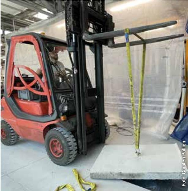
Gekonnt: Mit dosierter Staplerkraft wurden sehr feinfühlig schwere Betonplatten zerstörungsfrei herausgehoben. | Skillful: heavy concrete slabs were lifted out very sensitively and non-destructively with controlled forklift force.
