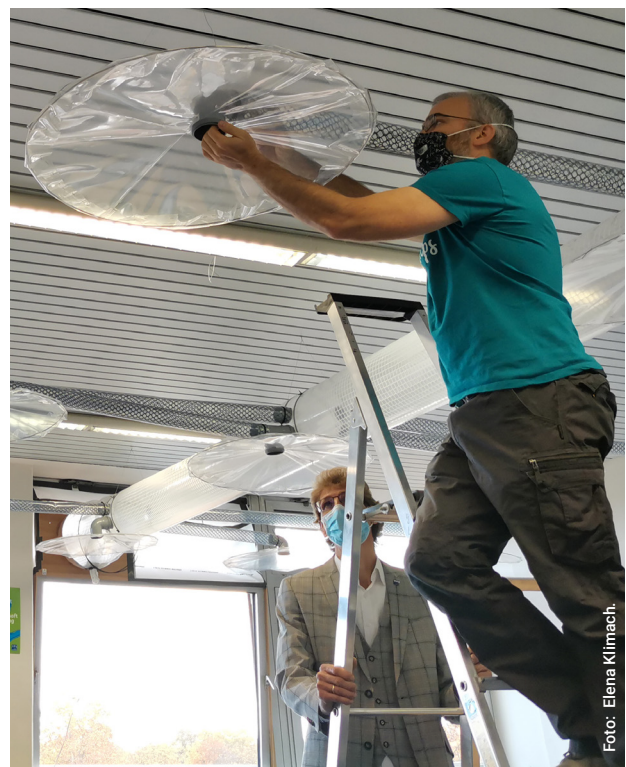
Ein einfaches Abluftsystem für Klassenräume: Thomas Klimach montiert eine der Hauben, die die warme Luft der Schüler über einem Tisch sammeln und in das Abluftrohr leiten soll. Im Hintergrund der Schulleiter der IGS Mainz-Bretzenheim, Roland Wollowski. | A simple ventilation system for classrooms: Thomas Klimach installs one of the hoods that collects warm air from the pupils above a table and directs it into the exhaust pipe. In the background, Roland Wollowski, the headmaster of the IGS Mainz-Bretzenheim.
